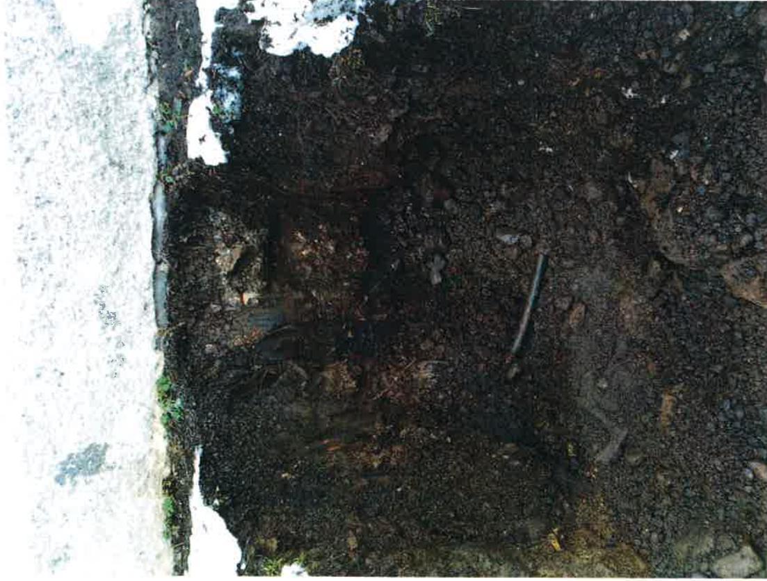
FOTO 1: Kopaná sonda KS1 pro ověření založení stávajícího jednopodlažního nepodsklepeného přístavku ve dvorním traktu.
