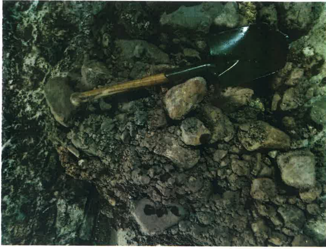
FOTO 2: Výkopek ze sondy zpod základové spáry obvodového pasu hlavního objektu ve sklepě na severní straně Lidového domu.
