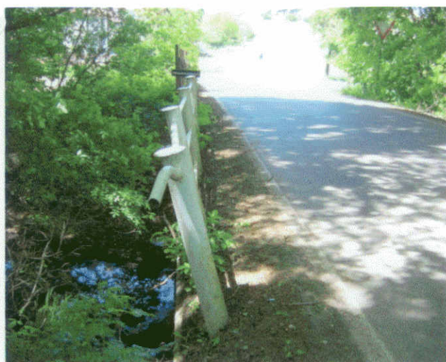
Pohled na zábradlí a římsu (protiproudni strana)
