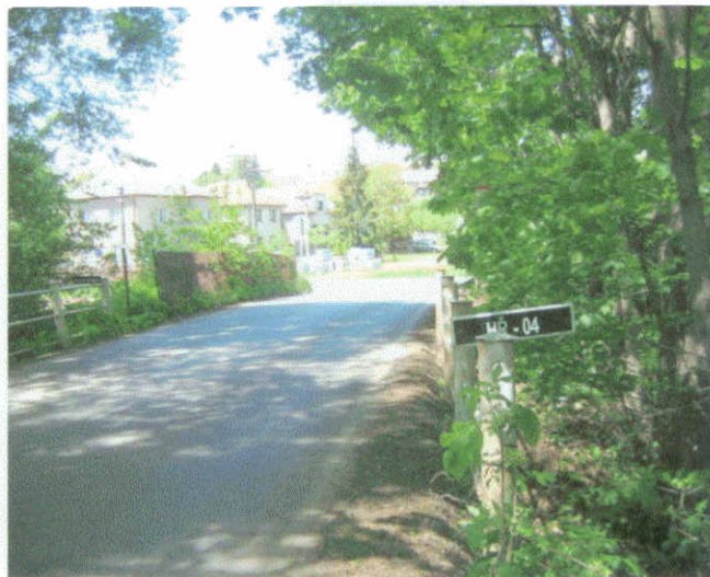
POhled na poproudni římsu, zábradlí.
