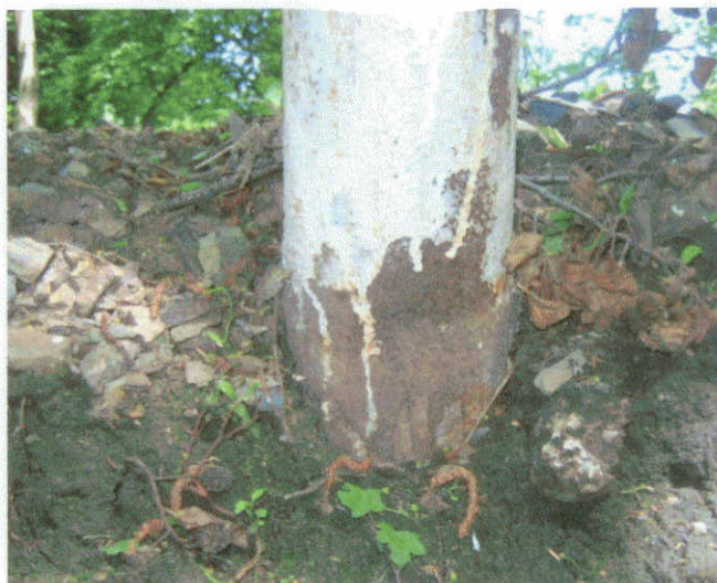
Detail ošetřené konstrukce sloupku zábradlí.
