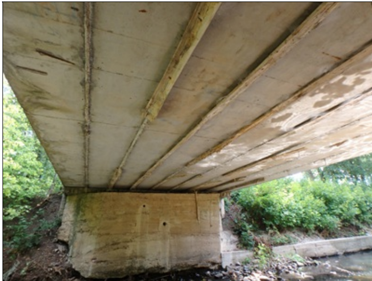
Spodní líc nosné konstrukce
