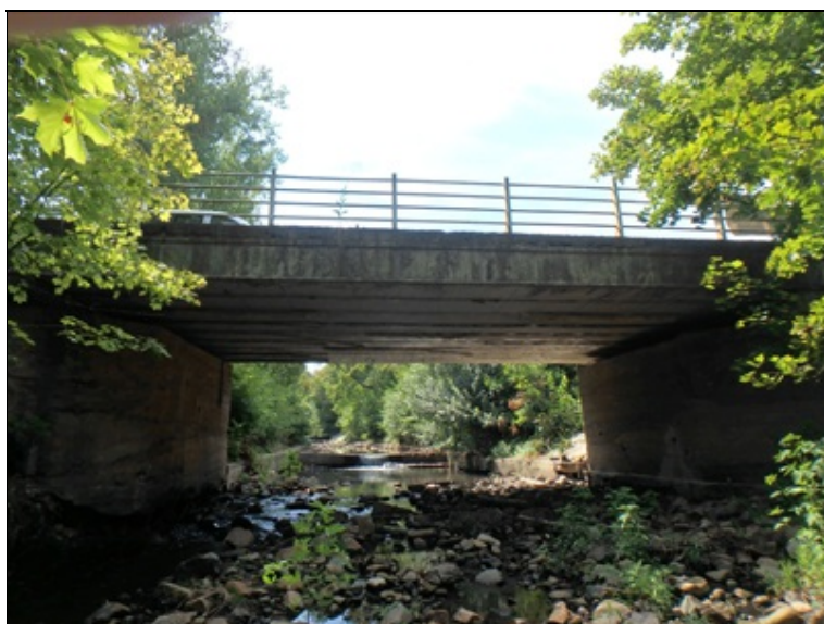
Pohled na levý bok mostu
