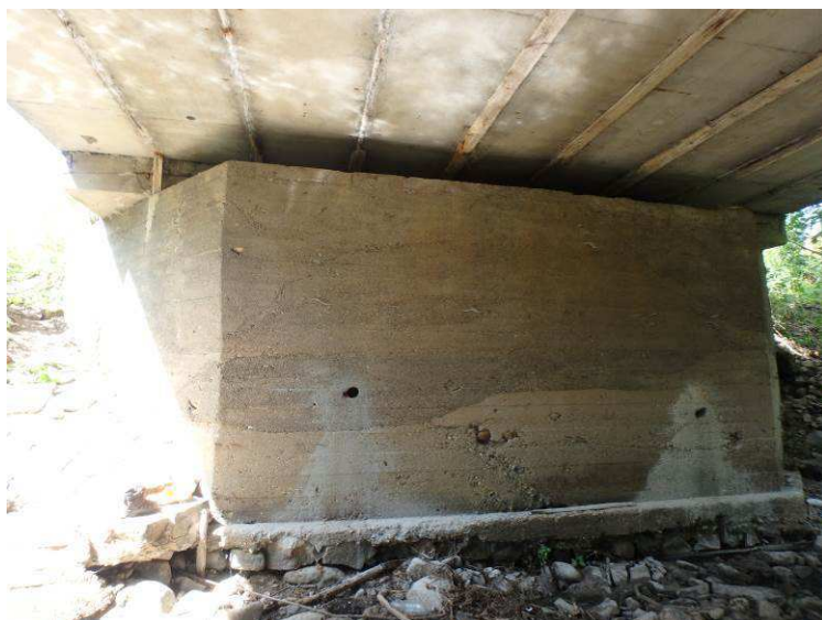
Obr. 2.6 – pohled na opěru OP1
