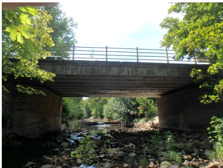
Obr. 2.3 - pohled na levý bok mostu
