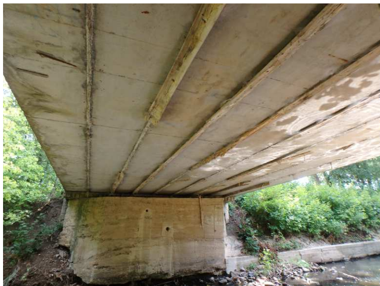
Obr. 2.5 – spodní líc nosné konstrukce
