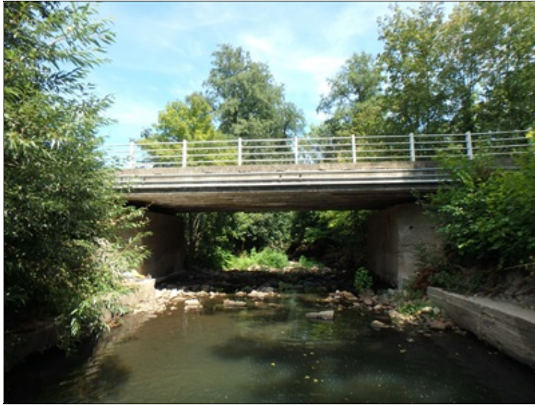
Pohled na pravý bok mostu
