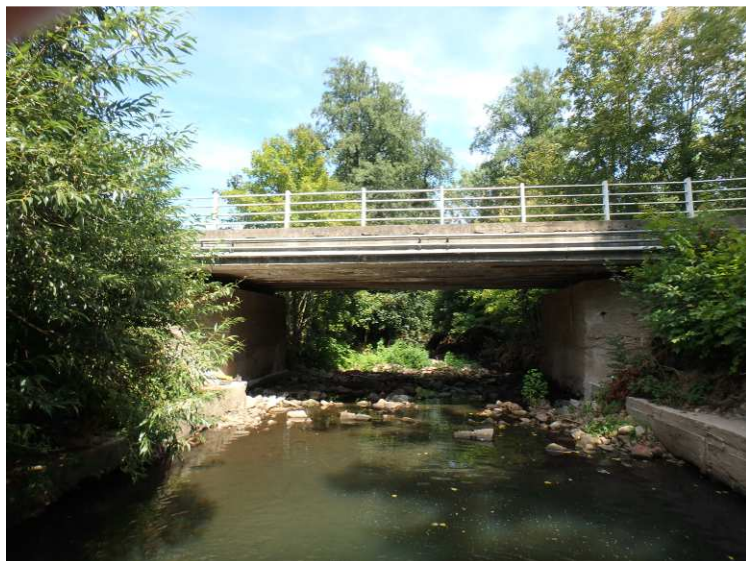
Obr. 2.4 - pohled na pravý bok mostu
