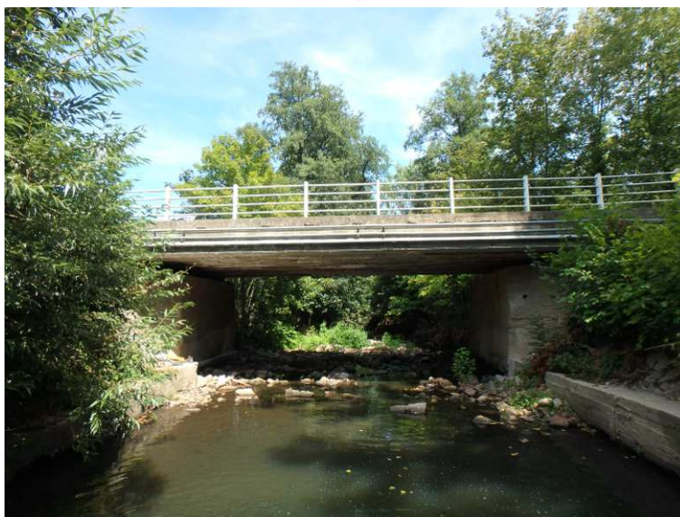
Obr. 1.2 – Pohled na levý bok mostu
