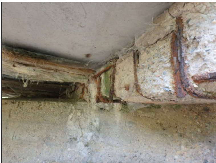
Vykonzolování pravé části úložného prahu opěry OP2, silná koroze betonářské výztuže úložného prahu
