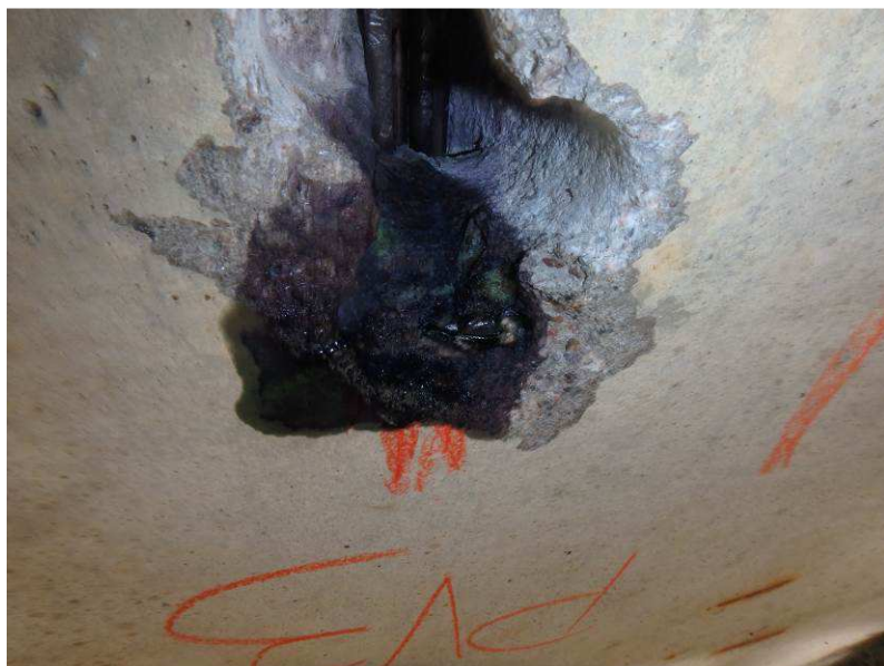
Obr. 3.18 – typický průběh karbonatace, zkušební místo K8 - bez karbonatace
