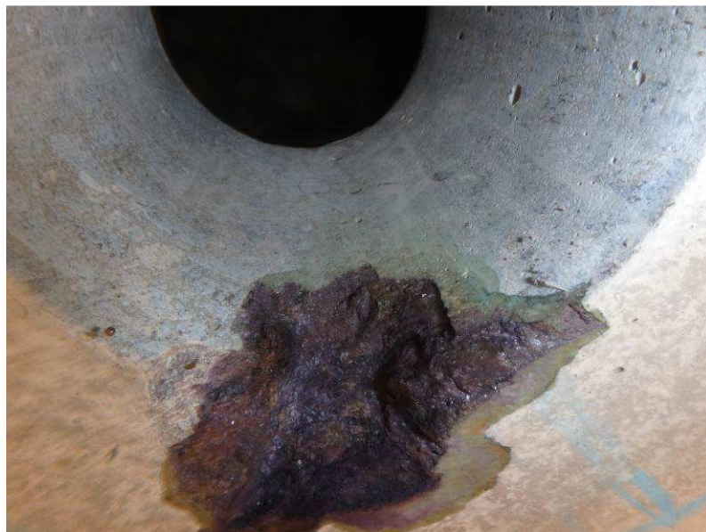
Obr. 3.20 – typický průběh karbonatace, zkušební místo K10 - bez karbonatace
