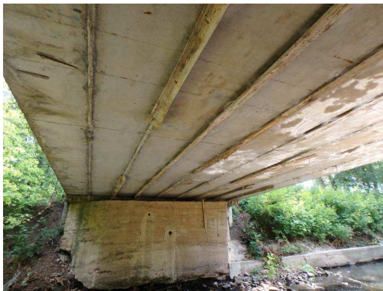
Obr. 1.3 – Spodní líc nosné konstrukce
