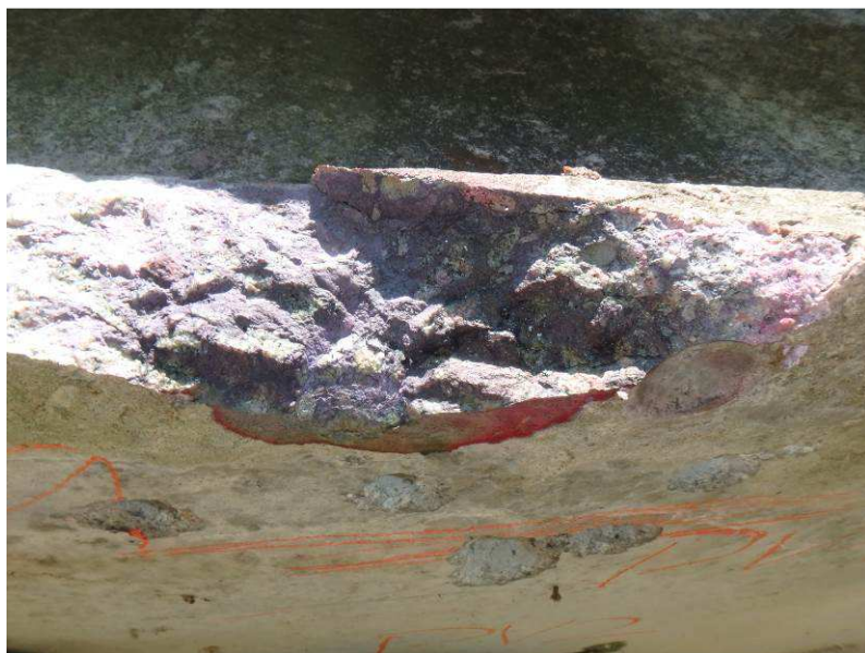
Obr. 3.19 – typický průběh karbonatace, zkušební místo K9 - bez karbonatace
