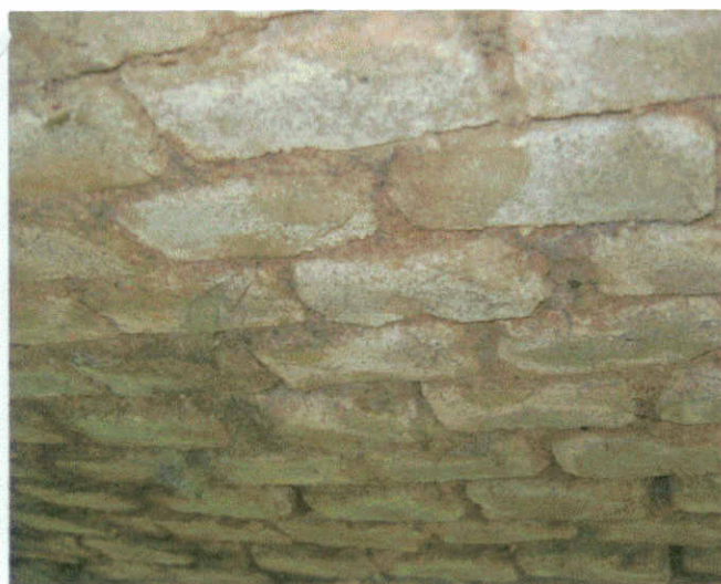
Detail cihelného zdiva klenby.
