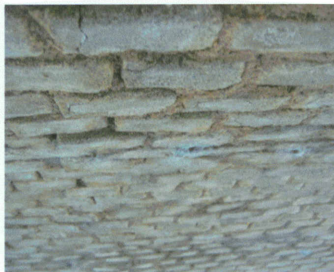
Detail pradkliny v cihelném zdivu.
