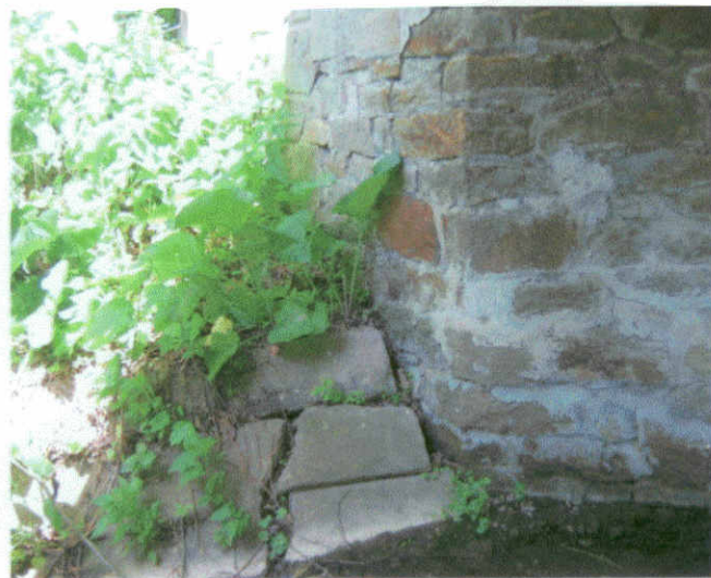
Detail paty svahového kužele poproudňí strana- (opěra O-II).
