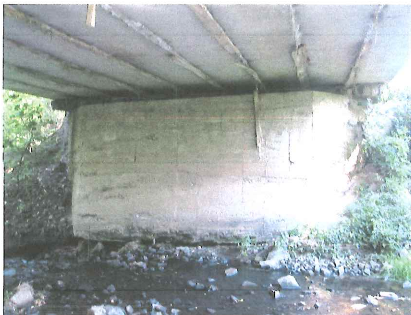
Podemletý dřík opěry OP1-detail.
