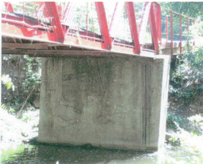
Pohled na pravobřežní podpěru.
