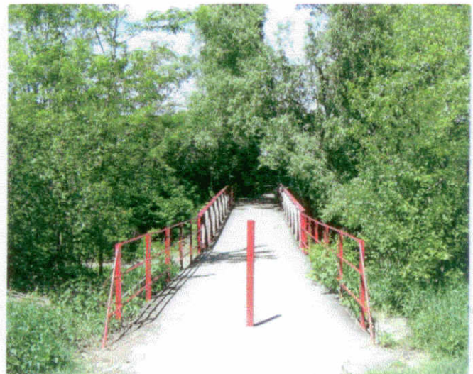
Celkový pohled na konstrukci lávky z pravého břehu.
